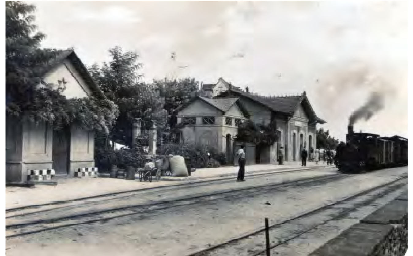
Vista general de l'estació. Viatgers esperant l'arribada del "carrilet" (Arxiu Xavier Romero)
